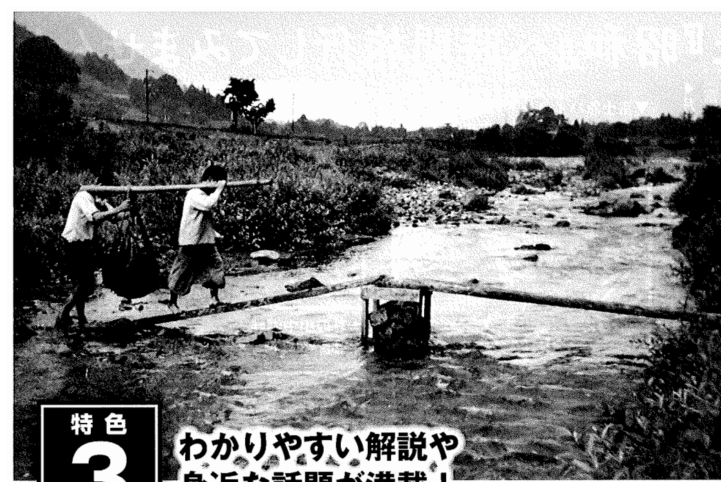
◀もっこを担いで 桂川に架かる簡易な橋を渡って人力で土砂の運搬をしている。台風や集中豪雨などによる災害に備えての作業だろうか。〈都留市鹿留・昭和30年頃・提供=滝口信安氏〉
